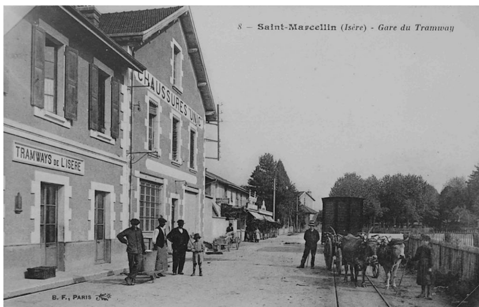
CPA – Saint-Marcellin, la gare du tramway et l'usine de chaussures Unic
