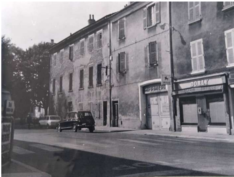
Bâtiment démoli (en 1971) – La porte « Romain Dutruc » se devine
