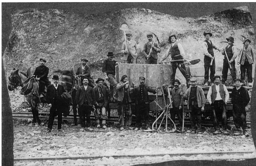
En hommage final, une équipe de travailleurs construisant la voie près de Dionay ... (C) Ch.G
