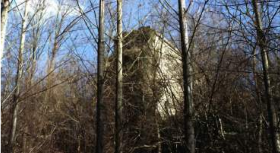
1982. Culée d'appui du viaduc sur la rive droite du Furan (Droits réservés : JB)
