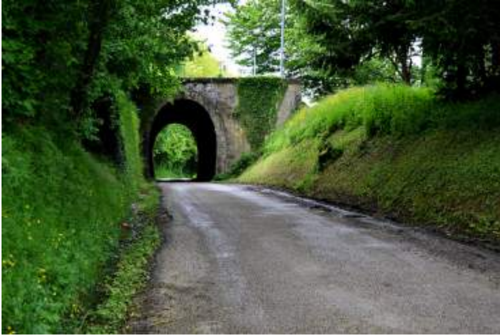
Le tunnel de Saint-Siméon de Bressieux en 2013 (Droits réservés:JB)
