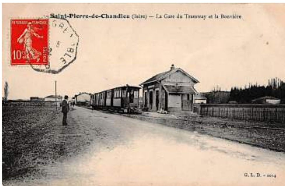
La gare de Saint-Pierre de Chandieu
