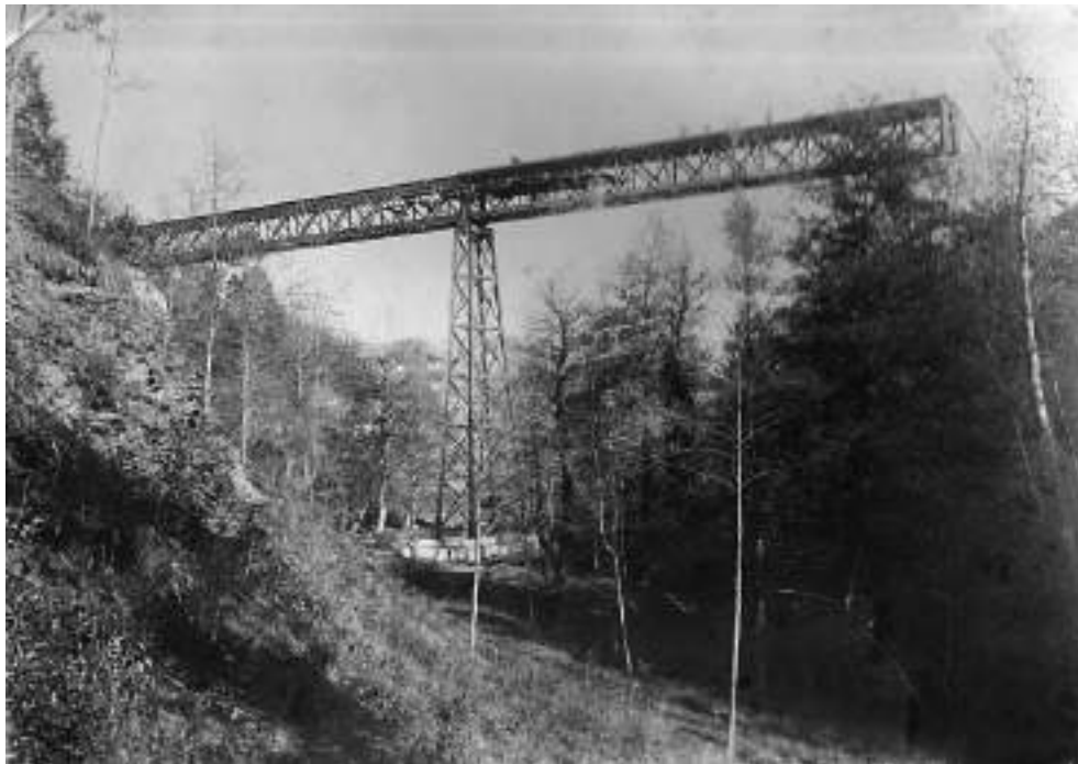
Viaduc sur le Furan, en construction. Photo privée Emile Guéraud
