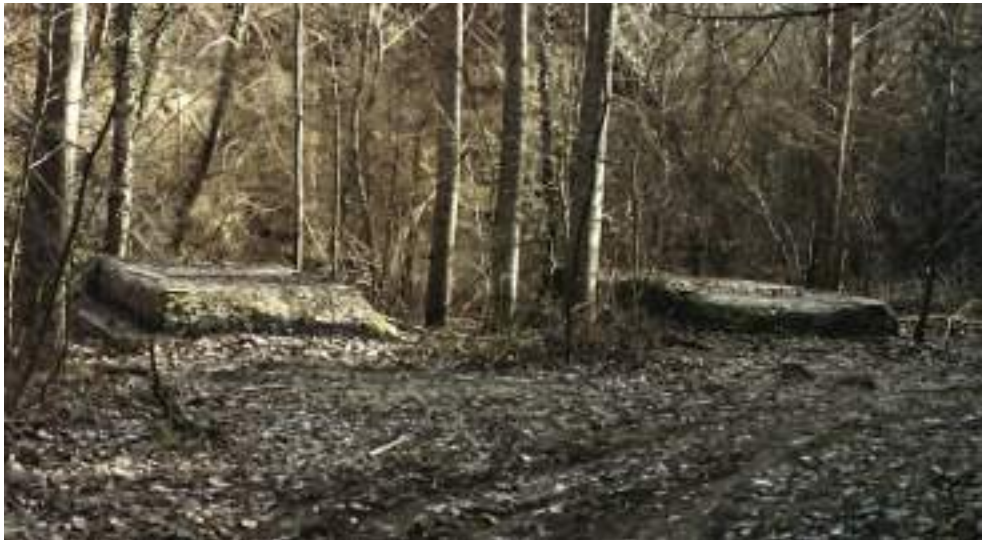
1982. Base du pilier du viaduc du Furan (Droits réservés : JB)
